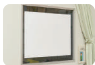
ガラス面貼付例
